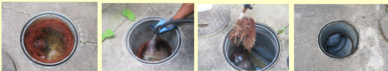
●これはアパート外枠の排水管です。アパート植え込みからの根が排水管まで入り込み、汚水の詰りを起こしてバルコニーに漏れ出していました。排水管には、食べ物のカス、油脂分、毛髪、糸くずなど様々な汚れが付着します。汚れが蓄積されると、排水不良や悪臭を発生させる原因となります。このような汚れを取り除き、排水管の流れが保たれれば、管の劣化を防ぐことにもなります。
