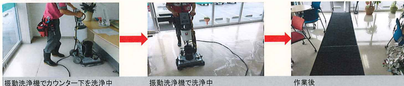
振動洗浄機でカウンター下を洗浄中
