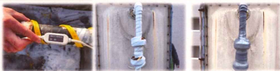
↑配管に新品のヒーターを取付
