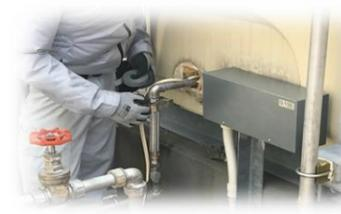
工程③配管ヒーター線巻き直し及びラッキング施工
