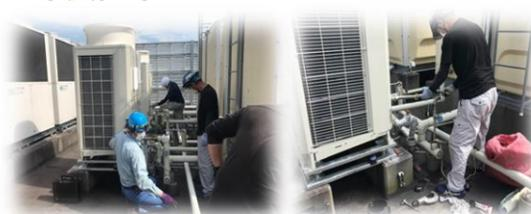
工程②新機種配管繋ぎ施工
