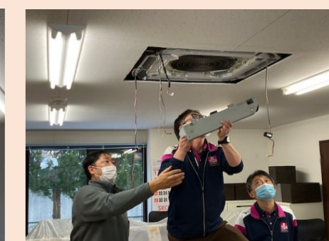
↑復旧作業の様子
