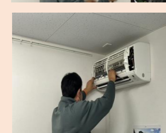
↑鎌戸社長のデモ施工
