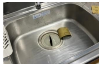
①清掃後に粗目の研磨シートで作業
