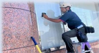
前作業としてハードタイプのスポンジにて表面の水垢に付着している汚れを手擦りで落ちていきます。地味～な作業ですが中々これが大変！このあとスクイジーでガラスを一旦切ります。
