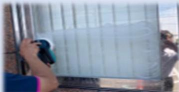
弱酸性薬品を塗布後、ハードタイプダイヤモンドパッドをサンダーに装着しガラス面に均等に力が加わるように押し当てていきます。この振動により固着している水垢が徐々に薄れていきます。(ノ
