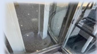
写真では分かりにくいですが建物正面ガラスほぼ全面に水垢が付着しています。薬品塗布、スポンジ擦りでもほぼ汚れは落ちません(´\_`)
