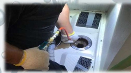
洗濯パンの高圧洗浄作業
