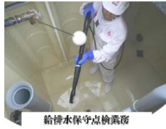
給排水保守点検業務
