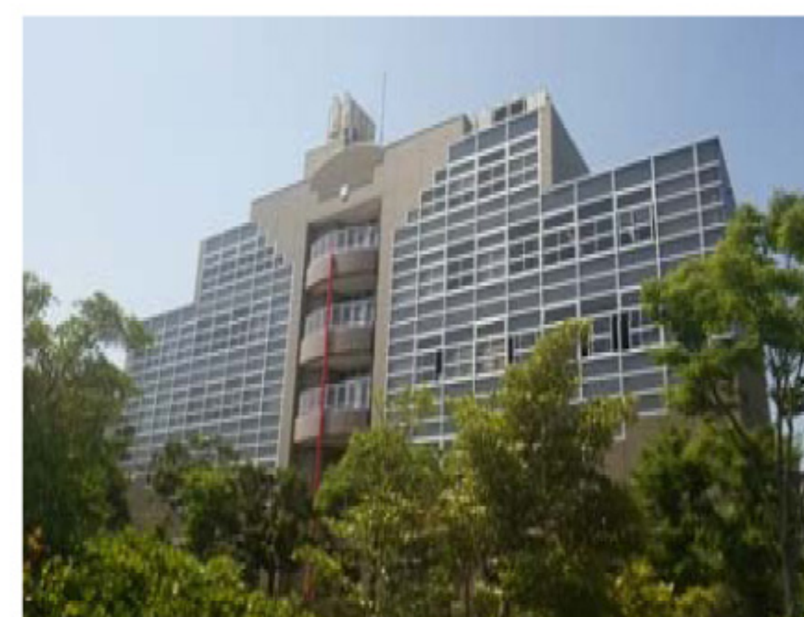
第1棟目 プレジデントシティビル
