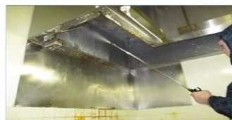
レンジフード 清掃中
