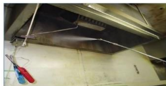
レンジフード 清掃中
