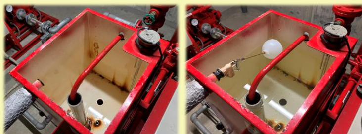
3 底に溜まった汚泥をきれいに取り除きます。
